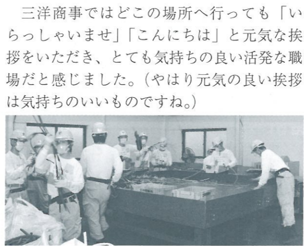
ケーブル皮膜除去作業風景
